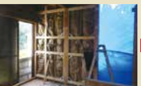
①既存の壁を一度剥がします。
