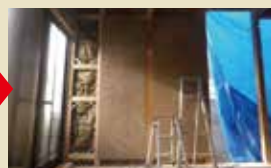
②耐震壁パネルを内側に設置。
